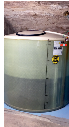
Haase-Kellertank (standortgefertigt)
